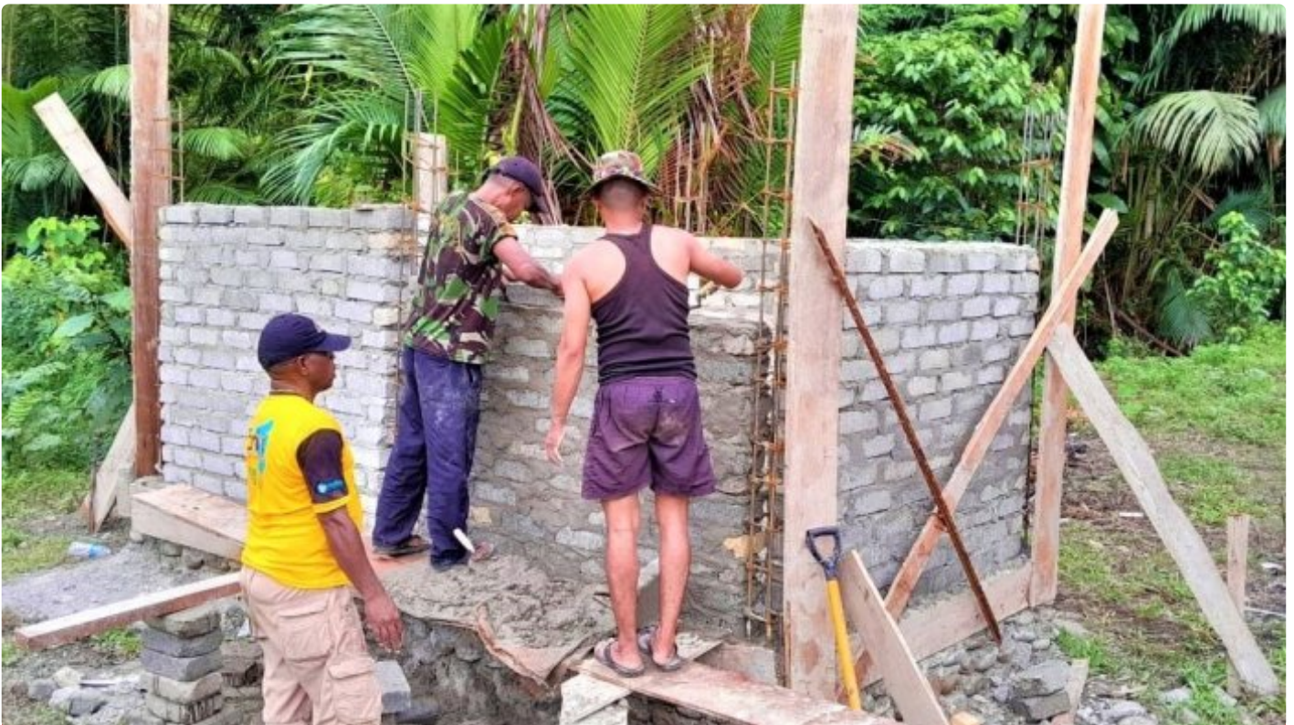
Satgas TMMD Saat Membuat Bak Penampungan Air Bersih Yntyk Warga Kampung Muara Nawa
